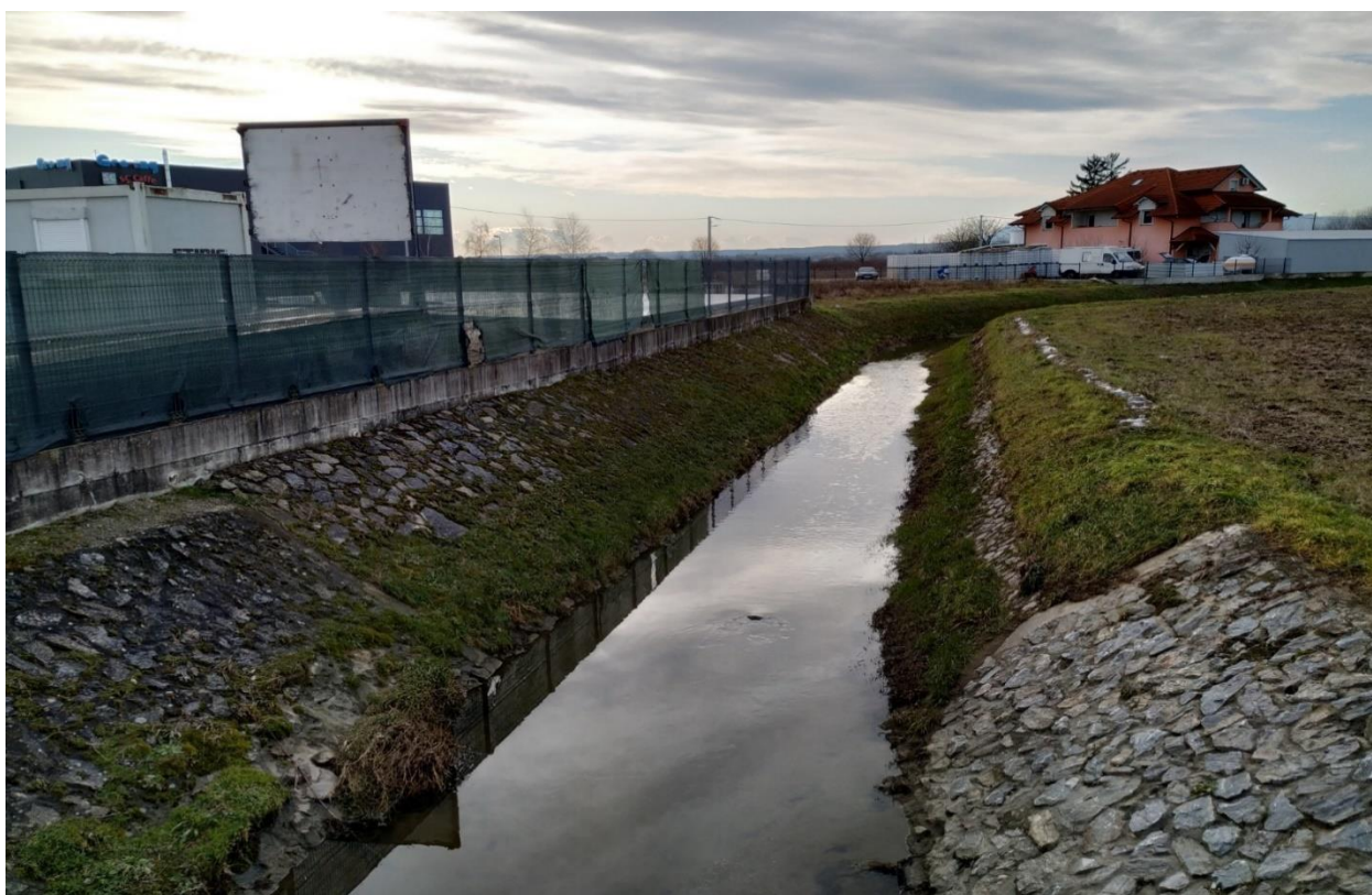
Slika 1.1/1 Predmetna dionica kod mosta u ulici Prkanj
