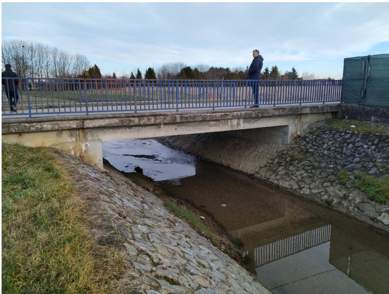
Slika 1.1/3. Cestovni propust u ulici Prkanj
